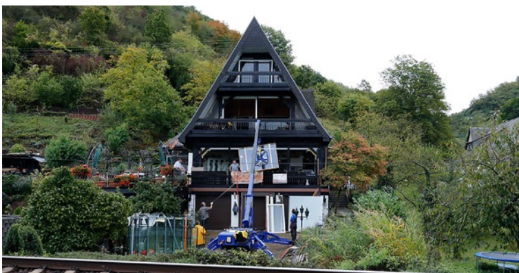
Beispiel für passive Schallschutzmaßnahme: Einbau von Schallschutzfenstern
