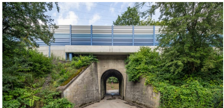
Beispiel für eine aktive Schallschutzmaßnahme: Schallschutzwand
